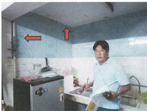
ผนังชนเสาด้านหลังอาคารฉีกร้าวด้านซ้าย มีน้ำซึมบริเวณรอยต่อผนังกับฝ้าท้องพื้นกันสาด
